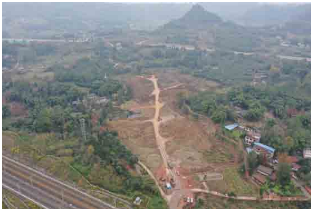
图 2.4-1 临时土方中转场现状
