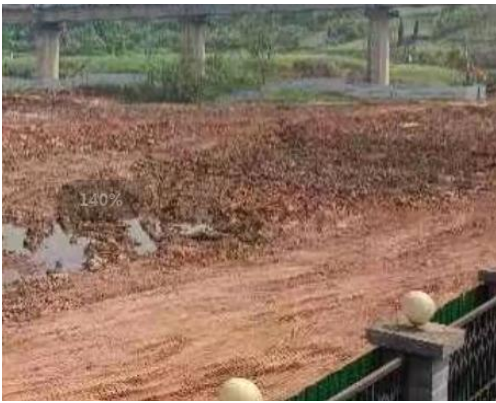
图 2.1.3 正在进行表土剥离
