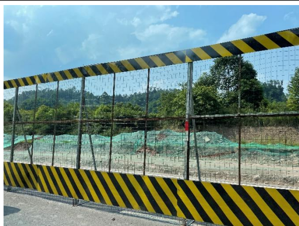
一环路现状（现场打围）
