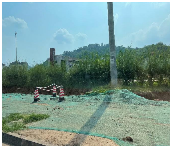
一环路现状（苫盖措施）
